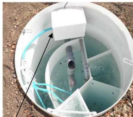
surpresseur d'air intégré dans un coffret interne à la micro-station (peut être déporté)
